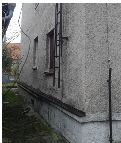
obr. /20/ Žebřík určený k výlezu na střechu
