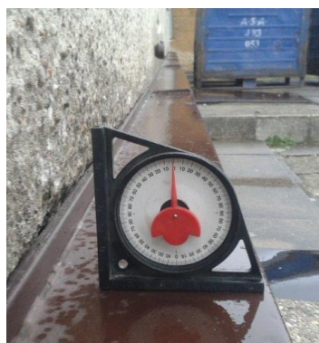
obr. /22/ Sklon oplechování soklového zdiva je místy 1^\circ směrem k obvodovému zdivu
