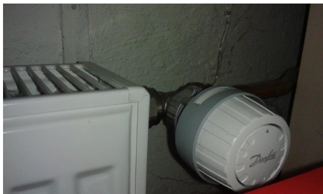
obr. /36/ Termostatická hlavice
