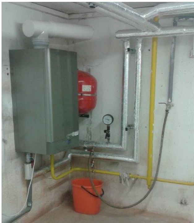
obr. /30/ Napojení plynovodu na plynový kotel
