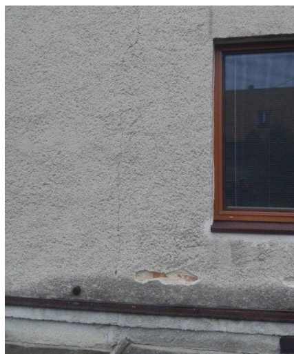
obr. /8/ Trhlina na fasádě v místě průvlaku
