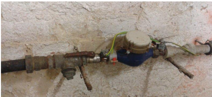
obr. /42/ Hlavní uzávěr vnitřního vodovodu
