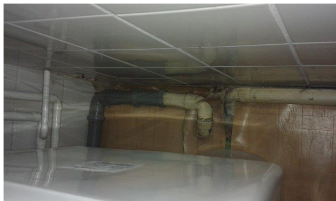
obr. /13/ Poškozené PVC v místě prostupu odpadů
