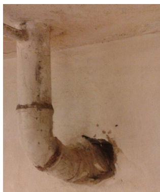
obr. /26/ Stávající kanalizační rozvody obr. /27/ Napojení vnitřní kanalizace na novou kanalizační přípojku
