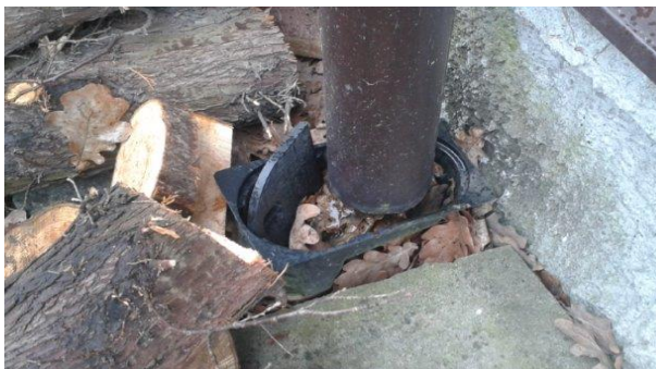
obr. /40/ Lapač střešních naplavenin
