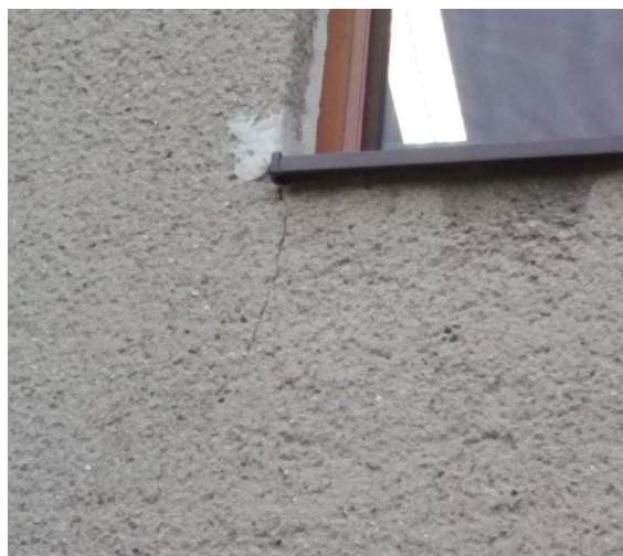
obr. /9/ Trhlina na fasádě pod parapetem okna
