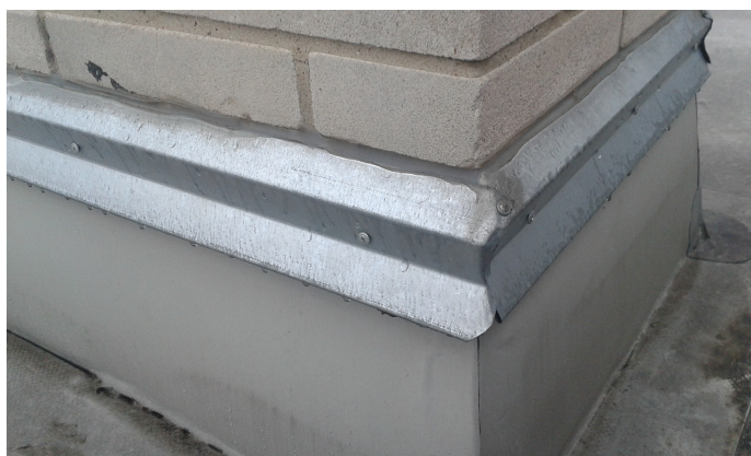
obr. /21/ Vytažení hydroizolace na komínové těleso
