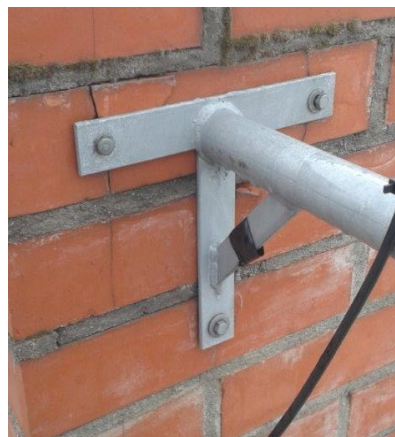
obr. /17/ Uvolněné kotevní prvky antény
