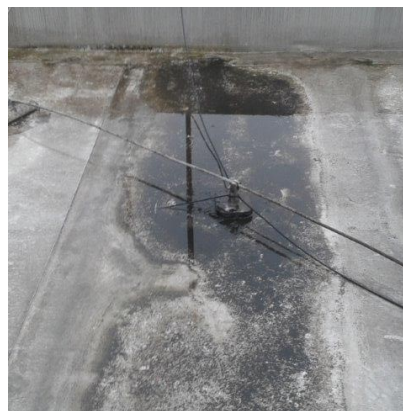
obr. /19/ Kaluže vznikající na hydroizolaci
