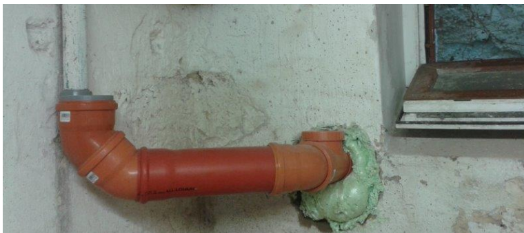
obr. /41/ Napojení vnitřní kanalizace na kanalizační přípojku
