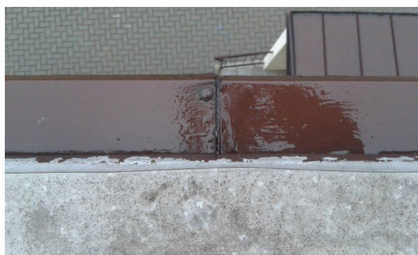
obr. /23/ Spoj oplechování atiky střechy není dostatečně vodotěsný
