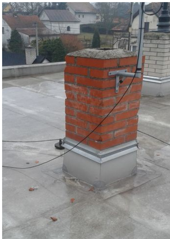
obr. /15/ Komínové těleso s absencí stříšky
