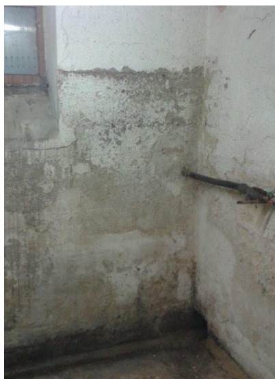
obr. /2/ Suterénní stěna smáčená vodou
