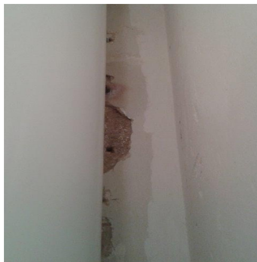
obr. /35/ Opadávající omítka za zásobníkovým ohřívačem teplé vody
