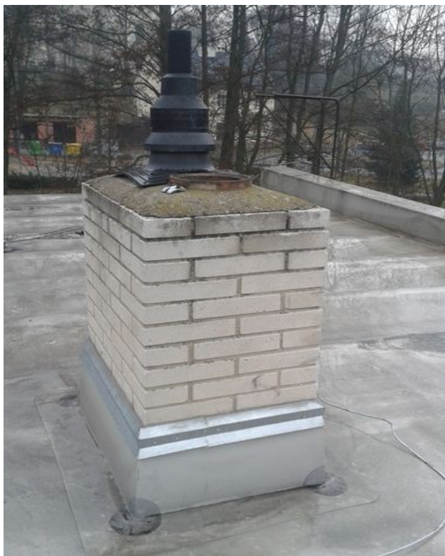
obr. /14/ Komínové těleso s absencí stříšky
