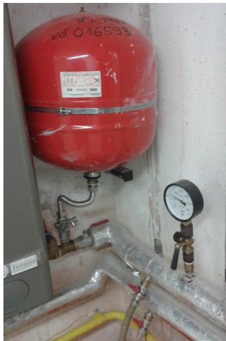
obr. /39/ Expanzní nádoba s tlakoměrem
