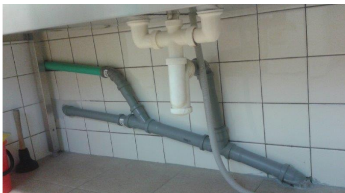
obr. /26/ Stávající kanalizační rozvody obr. /27/ Napojení vnitřní kanalizace na novou kanalizační přípojku
