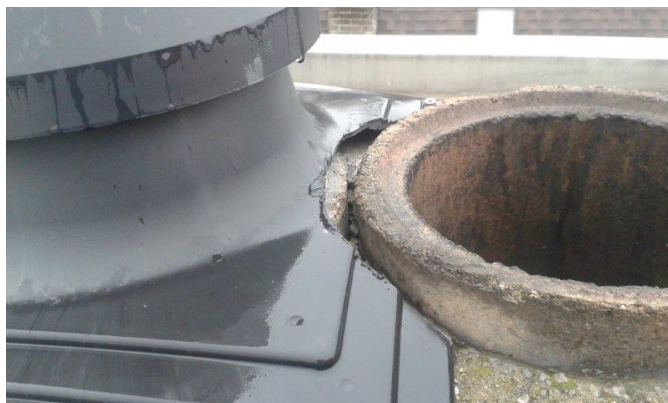
obr. /16/ Ukončení komínové stříšky
