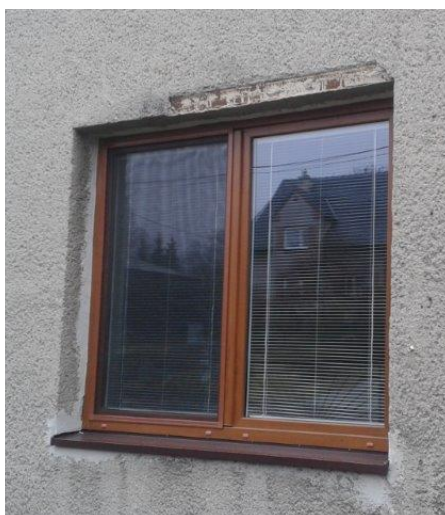
obr. /10/ Plastová okna s izolačními dvojskly
