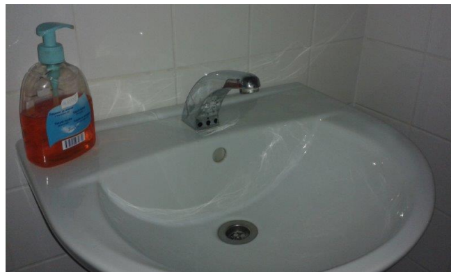
obr. /29/ Umyvadlová baterie s bezdotykovou technologií
