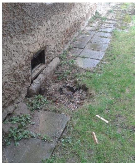
obr. /7/ Místo dopadu vody ze žlabu sousedního objektu
