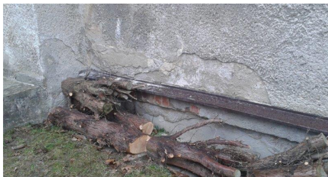
obr. /24/ Opadávající fasáda (ze dvora objektu) obr. /25/ Opadávající fasáda (ze strany příjezdové cesty)
