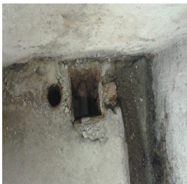
obr. /4/ Odvodňovací drážky v podlaze suterénu
