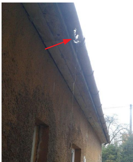
obr. /6/ Degradovaný podokapní žlab sousedního objektu
