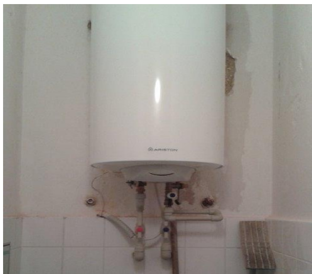
obr. /34/ Zásobníkový ohřívač teplé vody
