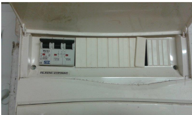
obr. /32/ Pojistná skříň s jističi
